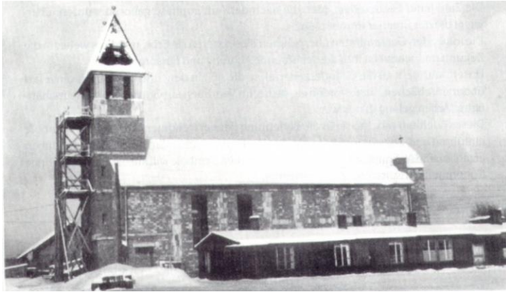
Gnadencapelle in Bau
